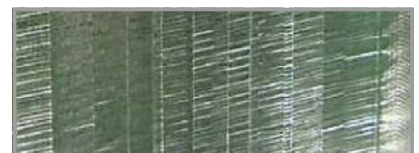
Conventionnel – Marques de vibration
